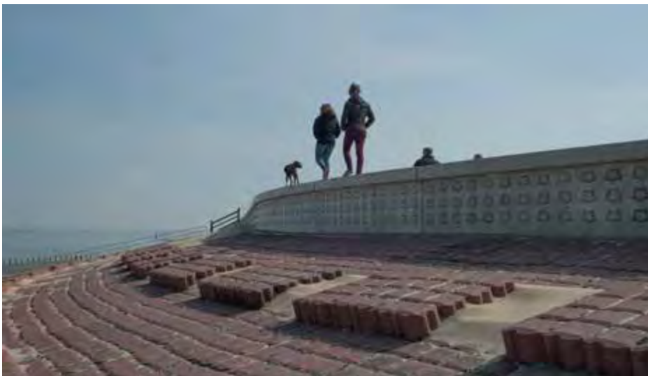
De bekleding van de versterkte dijk van Breskens, met erop een muur die golfoverslag tegengaat. Afbeelding 7.
