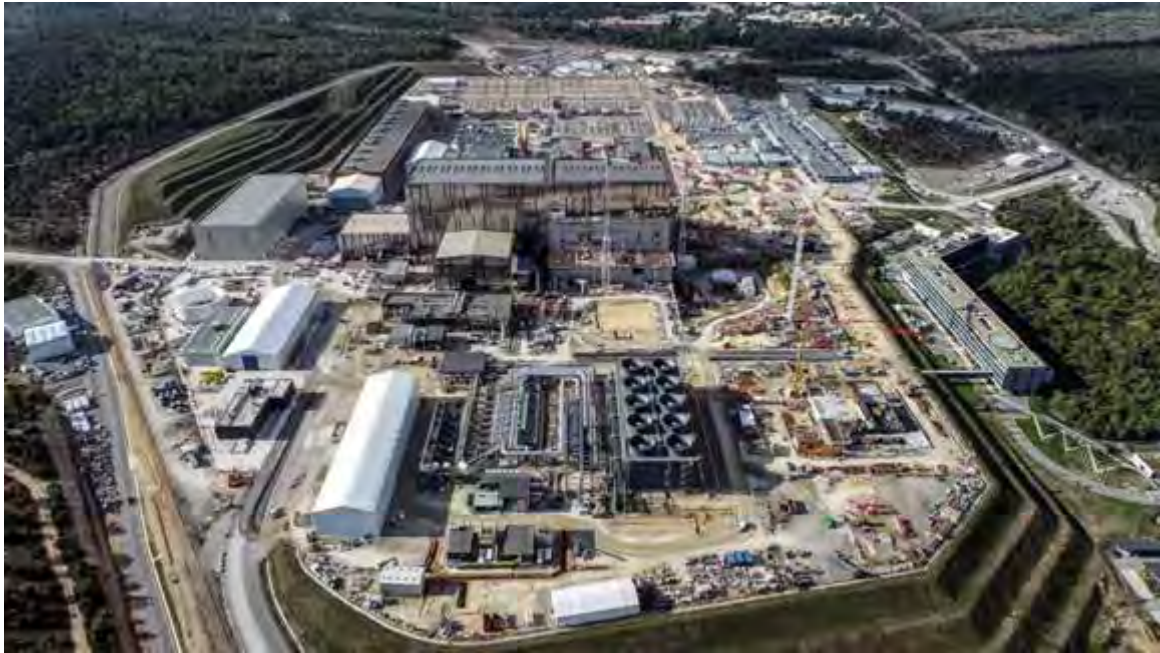
ITER complex ITER bouwen oktober 2021
